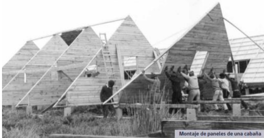
Montaje de paneles de una cabaña
